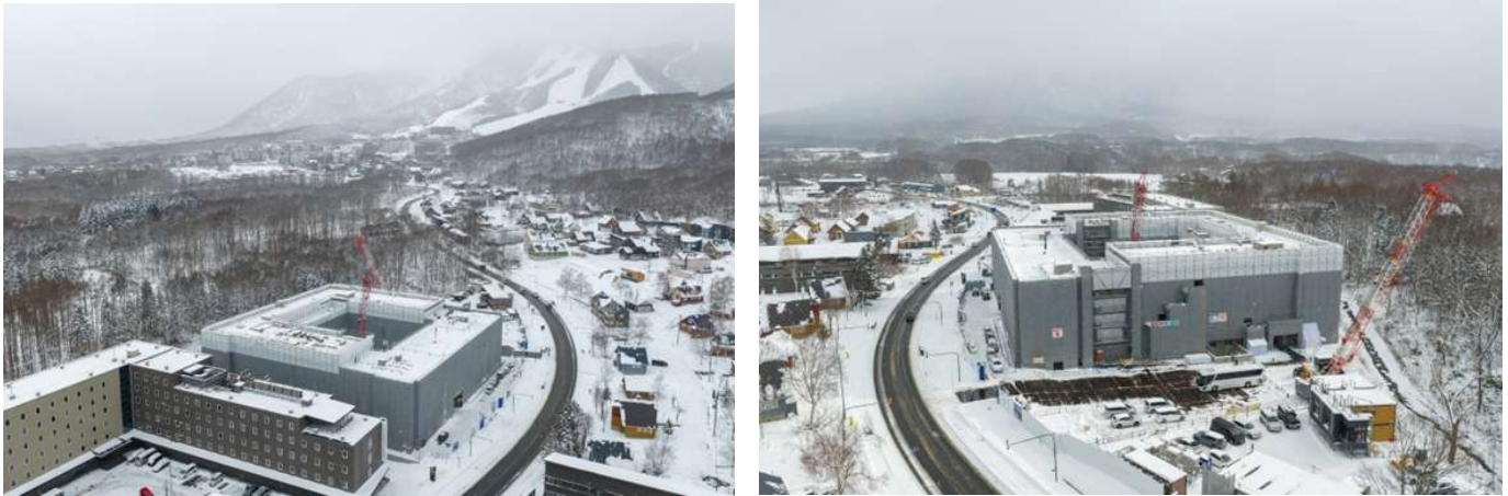
Actual Hotel101-Niseko Construction Photo
