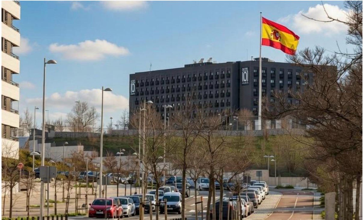
Actual Photo of 680-room Hotel101-Madrid
