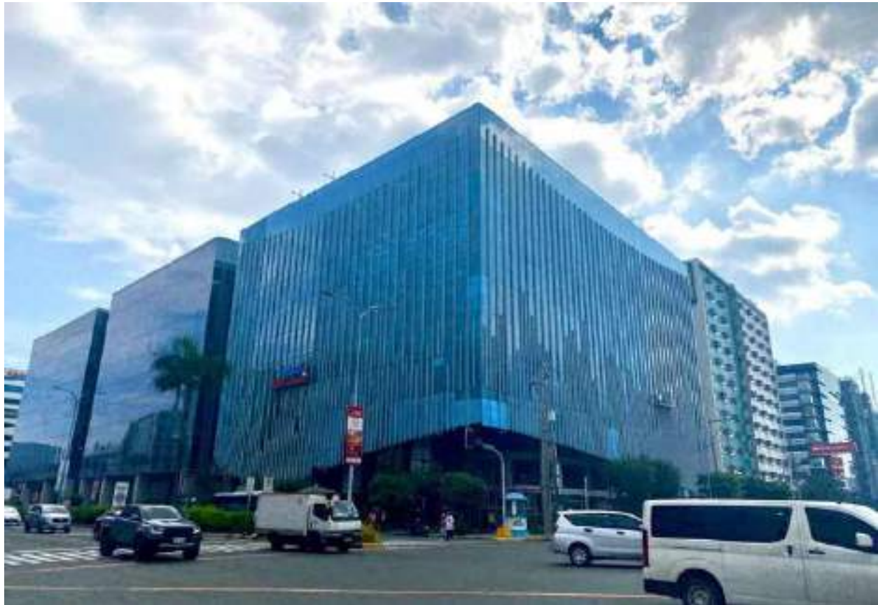
Actual photo of DD Meridian Tower
