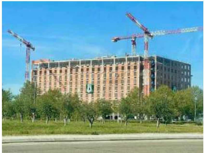
Actual Hotel101-Madrid Construction Photo
