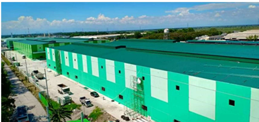
Actual photo of CentralHub-Tarlac
