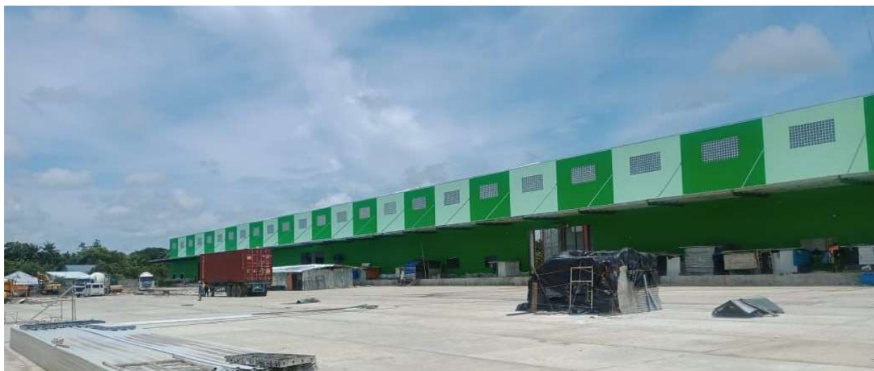
Actual photo of CentralHub-Iloilo
