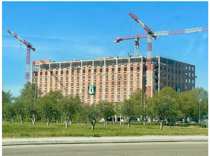
Actual Hotel101-Madrid Construction Photo
