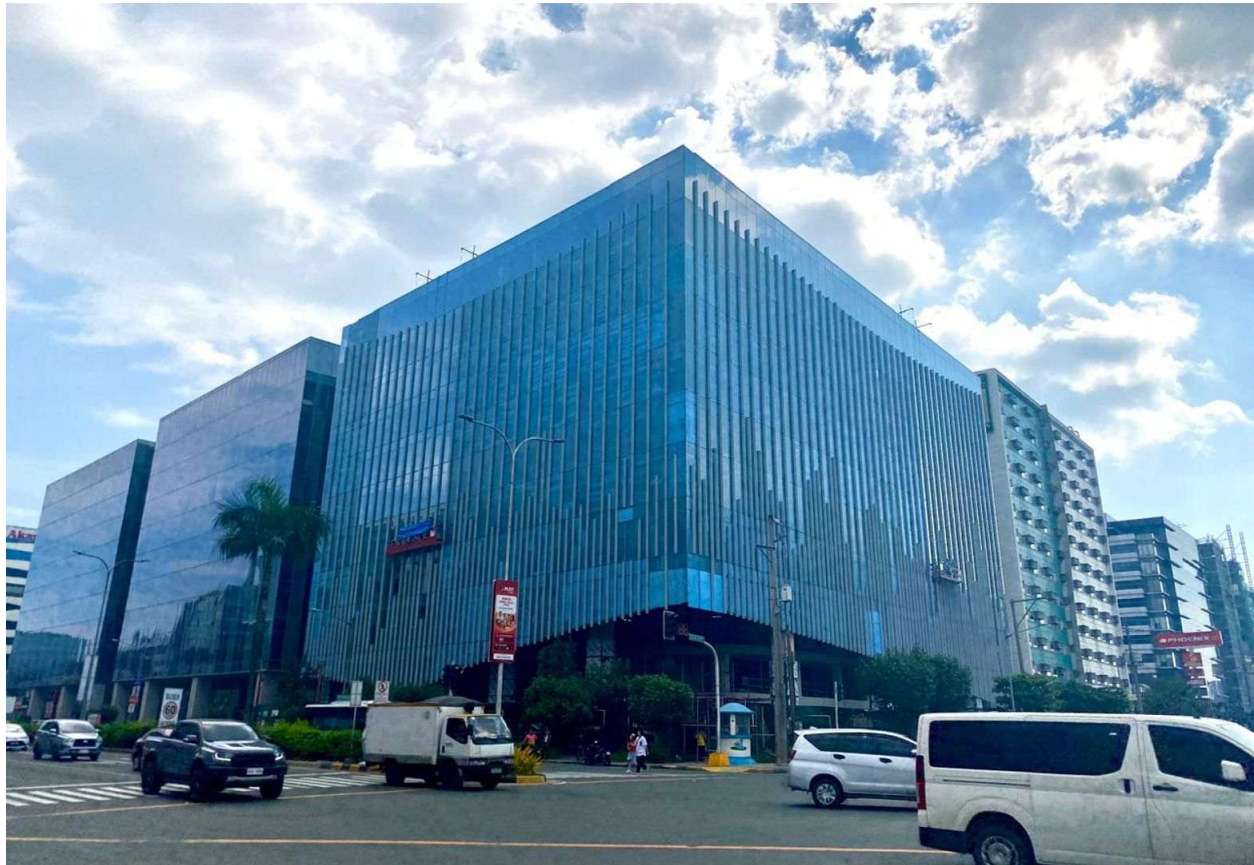
Actual photo of DD Meridian Tower
