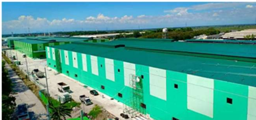
Actual photo of CentralHub-Tarlac
