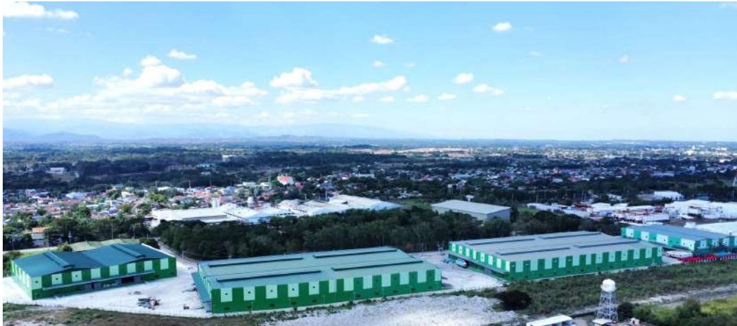
Actual photo of CentralHub-Tarlac
